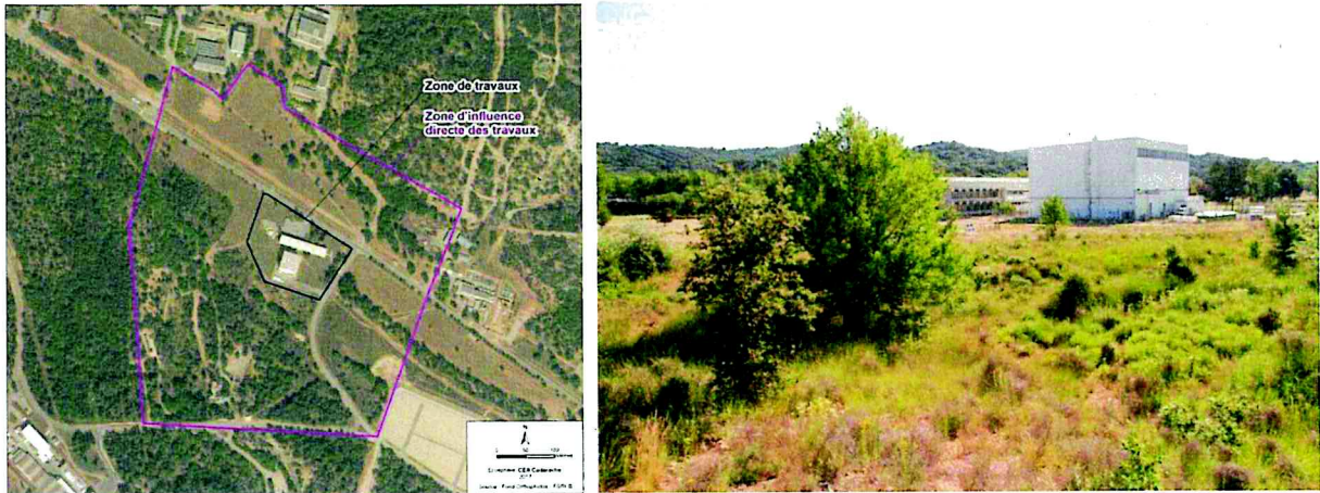
Figure 3 : Vue aérienne et vue ouest du bâtiment des installations EOLE et MINERVE (Source : dossier)
